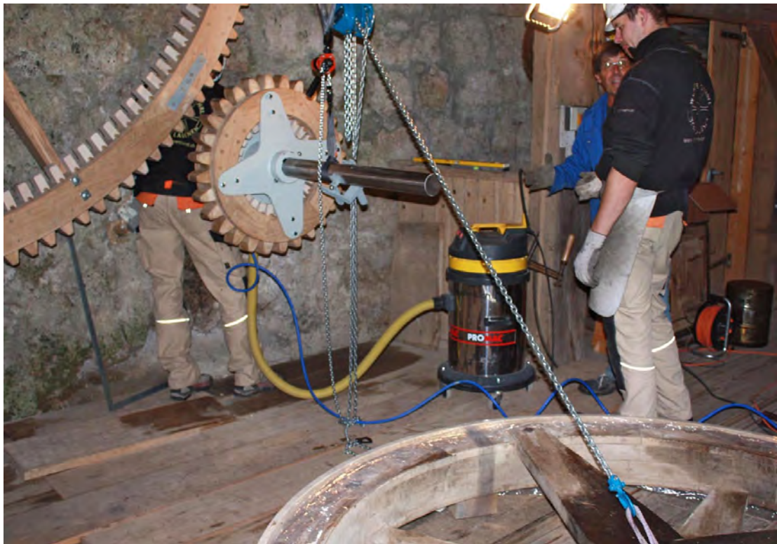
Zusammenbau der Übertragungsmechanik. Das kleine Zahnrad übersetzt die Kraft vom Wasserrad so, dass das Sägegatter genügend Schwung hat. (Foto Hans Lüthy)
