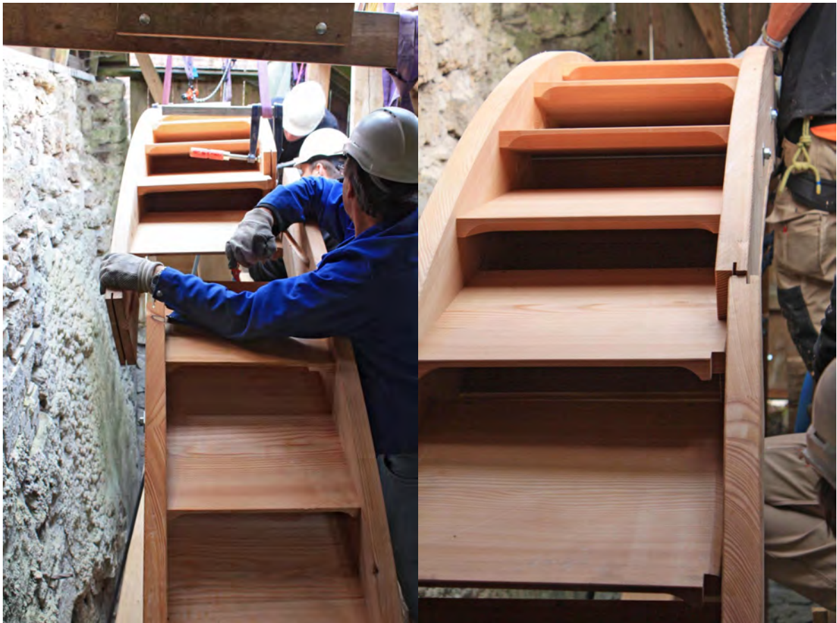
Noch ein paar Handgriffe und aus den vorgefertigten Puzzleteilen wird ein Wasserrad entstanden sein. (Fotos Hans Lüthy)
