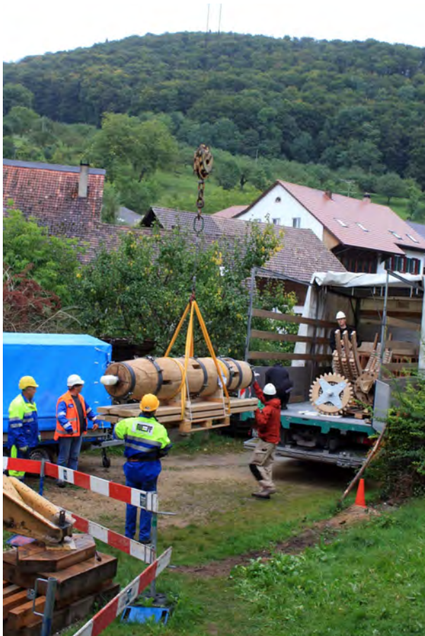
Die neue Wasserradachse hängt bereits am Kran. (Foto Hans Lüthy)
