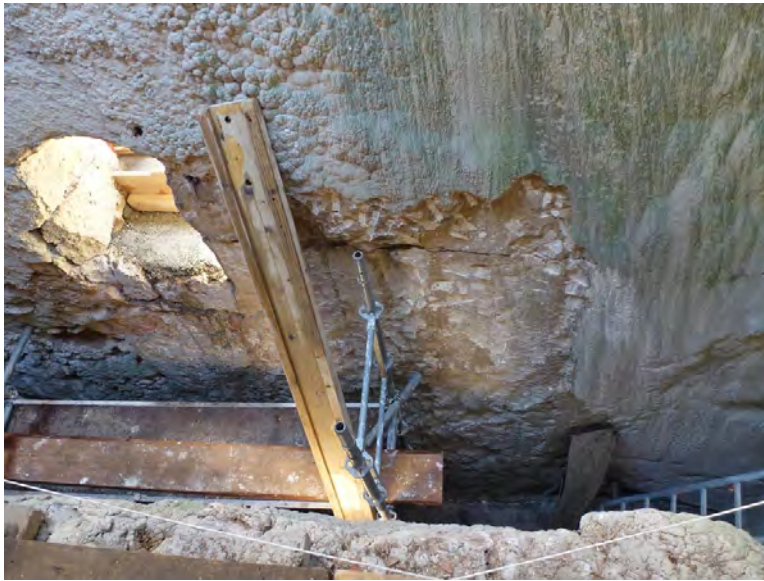
Die Westmauer nach dem Abspitzen der Kalkablagerungen. Das 'Fenster' links im Bild ist für das Achslager des Wasserrads vorgesehen. (Foto Urs Weber)
