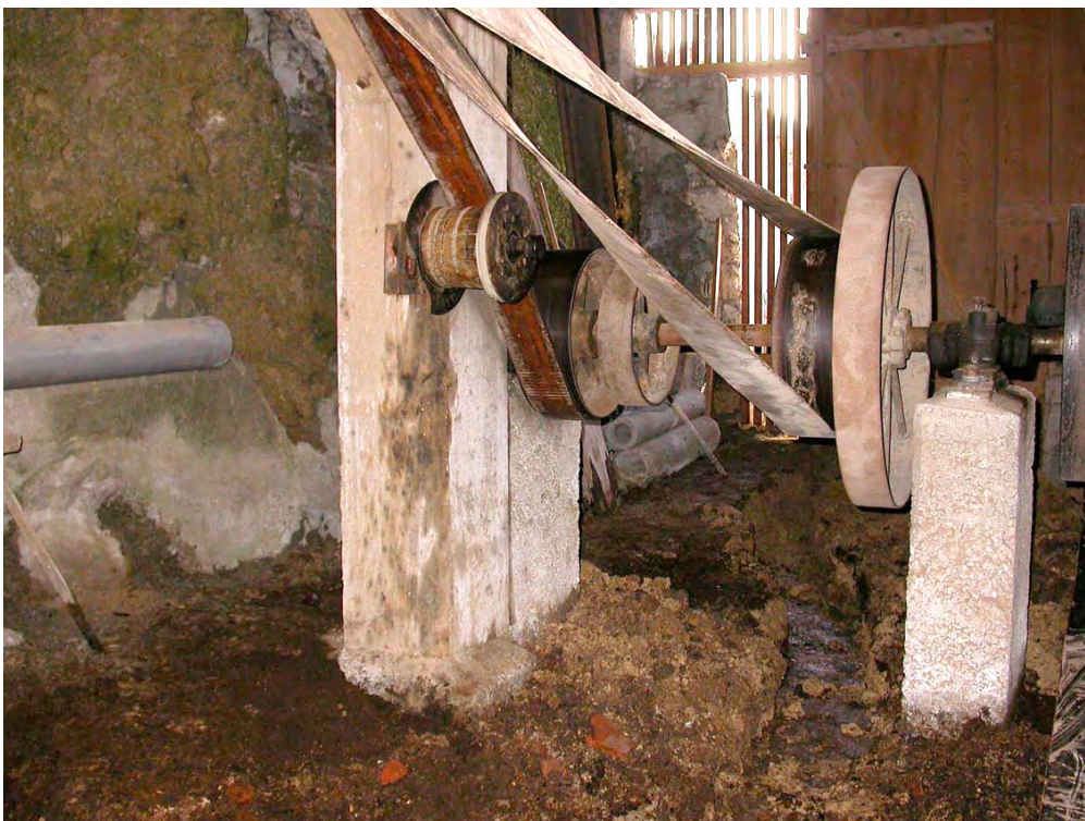
Der Wassereinbruch vom April 2006 hat den Sägekeller mit einer dicken Schlammschicht überzogen. Die Übertragungsmechanik wurde davon glücklicherweise nicht in Mitleidenschaft gezogen. Die weitsichtigen Erbauer der Sagi haben solche Naturereignisse in ihre Überlegungen einbezogen und die Räder für die Transmissionsriemen in sicherer Höhe montiert.
