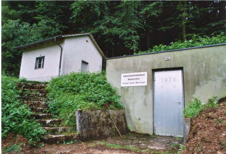
Die Pumpstation für das Wasser der Gallislochquelle, welche die Lebensader von Öttingen, Anwil und Wenslingen ist. Foto .
