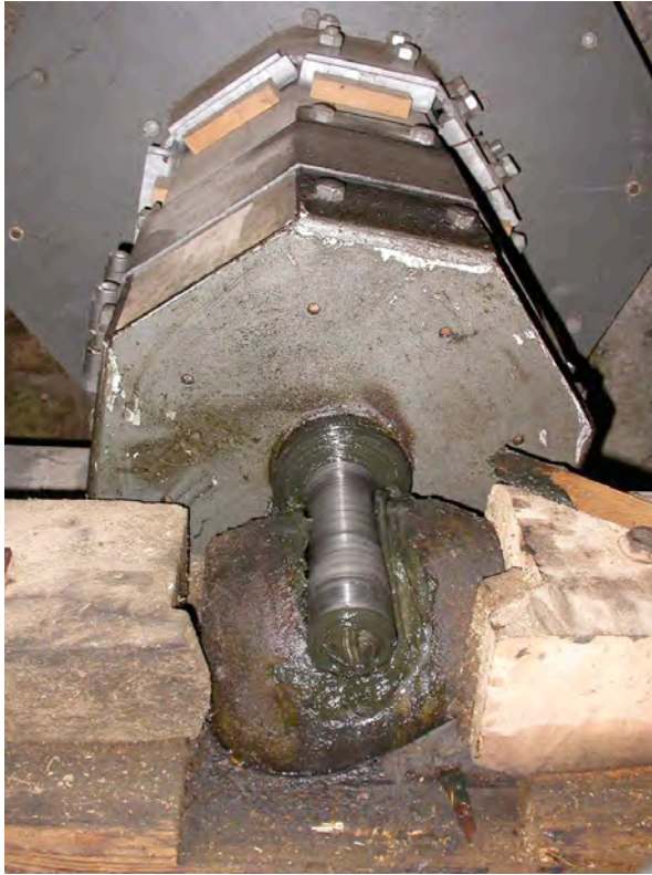
Steinlager der Wasserradachse. Die Lager müssen stets sehr gut gefettet sein.
