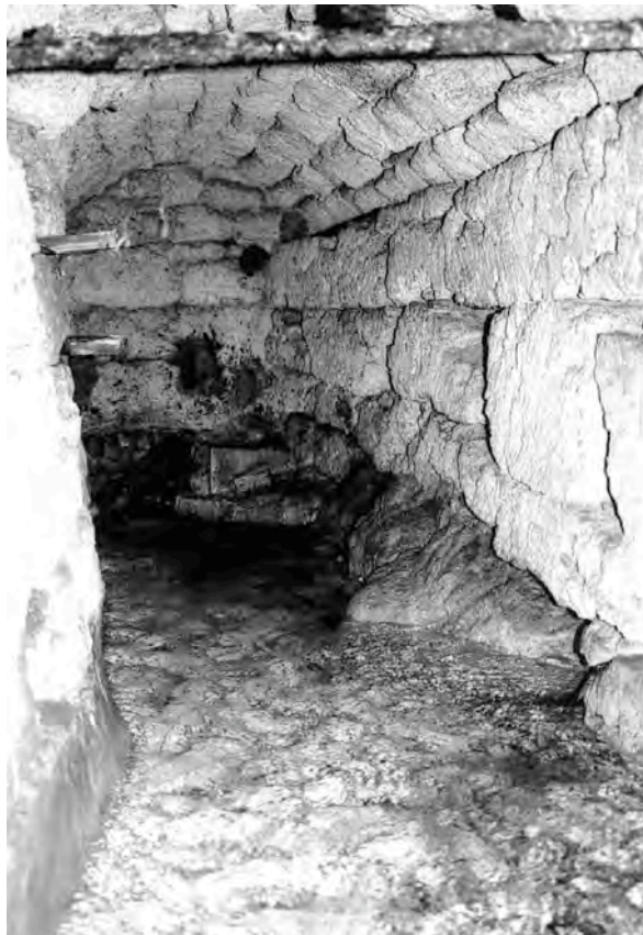
Quellfassung der Gallisloch-Quelle. Hier entspringt normalerweise die Ergolz. Foto Franz Herzog.
