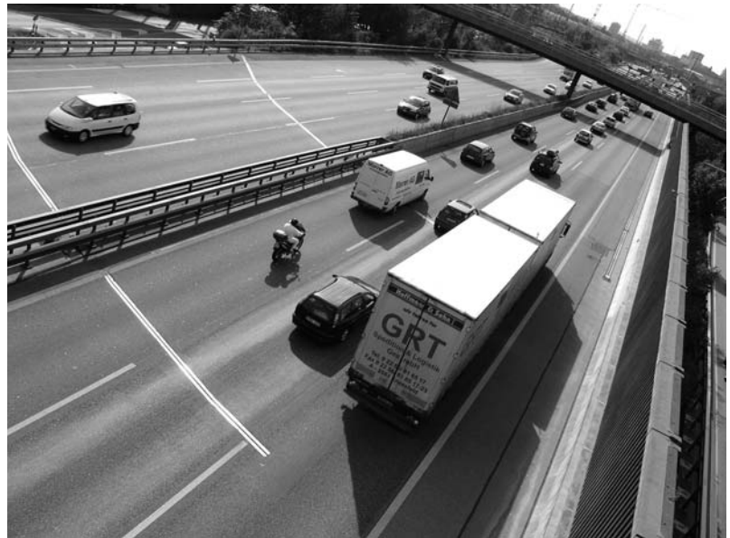
Nationalstrasse A2 Basel - Augst (Bildnachweis: AUE, F. Häner)
