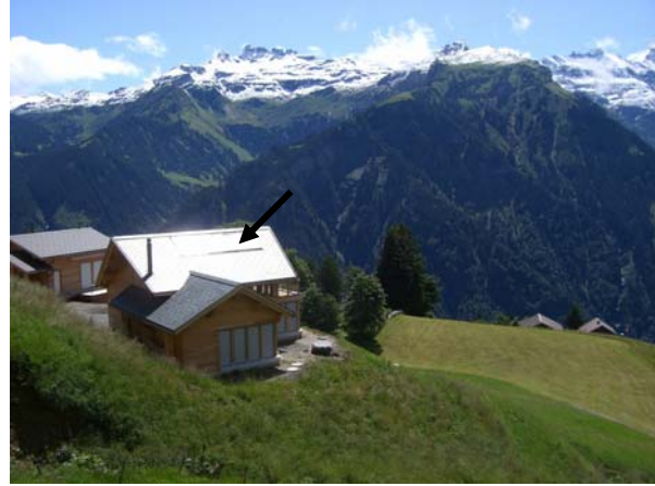
Foto 2: Dachfläche mit integrierter Solaranlage (vgl. Pfeil). Von Dachfläche und Solaranlage geht eine vergleichbare Blendwirkung aus.
