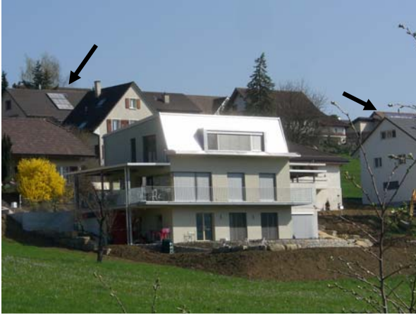
Foto 1: Dachfläche mit Blendwirkung (ohne Solaranlage) im Vordergrund. Solaranlagen ohne Blendwirkung im Hintergrund (vgl. die beiden Pfeile).
