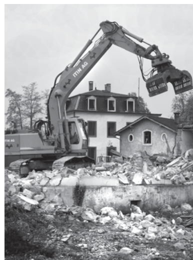
Ein Bagger reisst das alte Wohnhaus an der Bahnhofstrasse ab.
