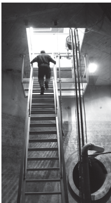
Im Mischwasserbecken bei der Grün 80 ist alles in Ordnung.
