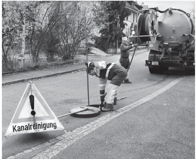
Friedrich Dürrenberger (hinten) und Andreas Bader reinigen einen Kanalisationsabschnitt bei Aesch.
