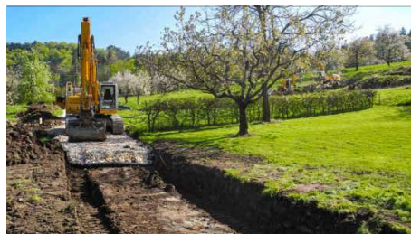
Eine Wegsanierung bei Wahlen BL.
