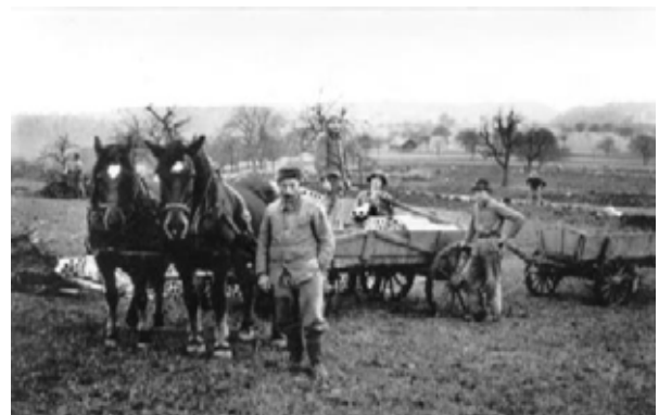
Entwässerungsarbeiten: Während dem 2. Weltkrieg wurden allein in Wenslingen 173 Hektaren Land drainiert. (Quelle: Archiv Spinnler, Tecknau)
