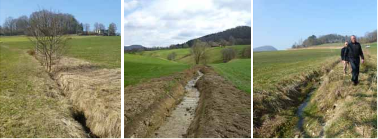
Der Stellibach 2012 vor und nach der Aufweitung (Foto: R. Christ) sowie im März 2014 begrünt (Foto: P. Hufschmid)
