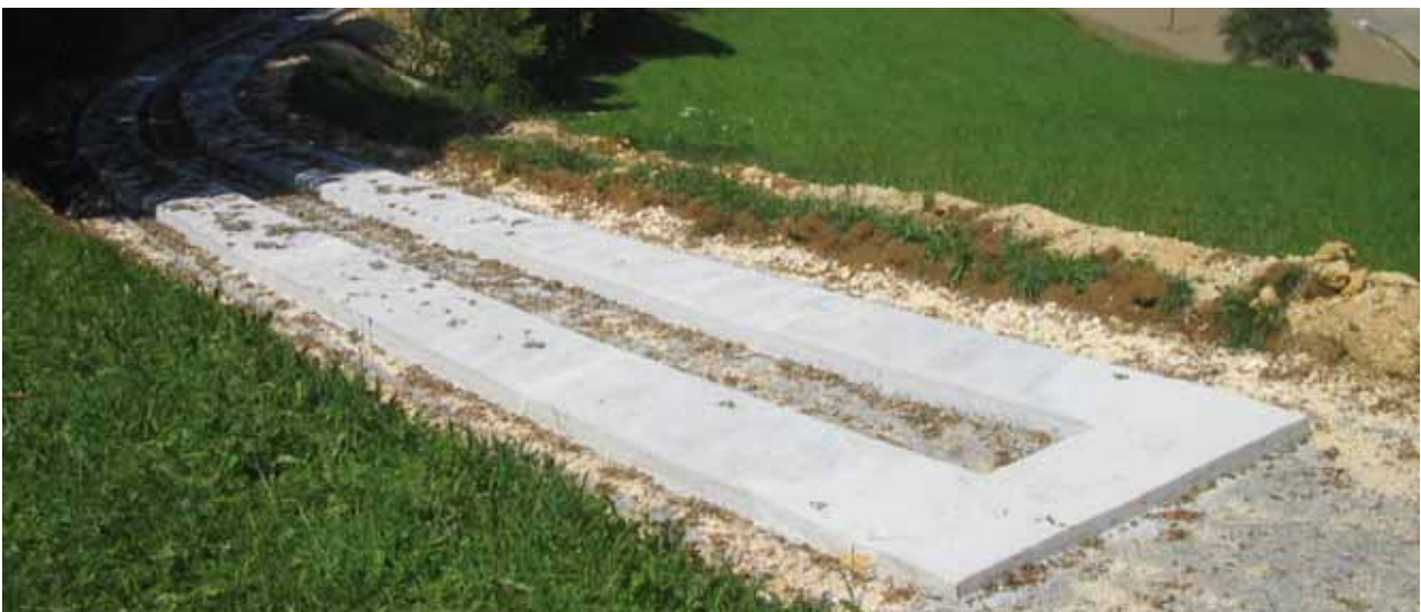
Betonspurweg im Bau, Milzeried, August 2005
