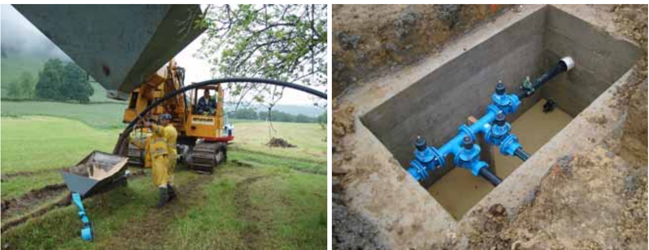
Leitungseinzug zur Welschmatt sowie Verteilerschacht, Juni 2008
