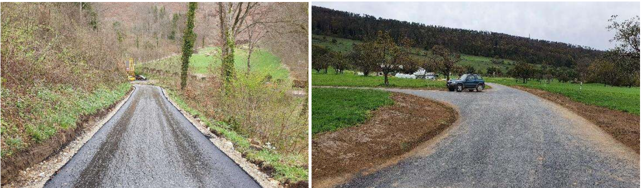
Sanierung Nenzlingerweg bei Panzersperre und Kreuzung beim Schrägen Weg, Etappe 8 (Fotos: Ebenrain)
