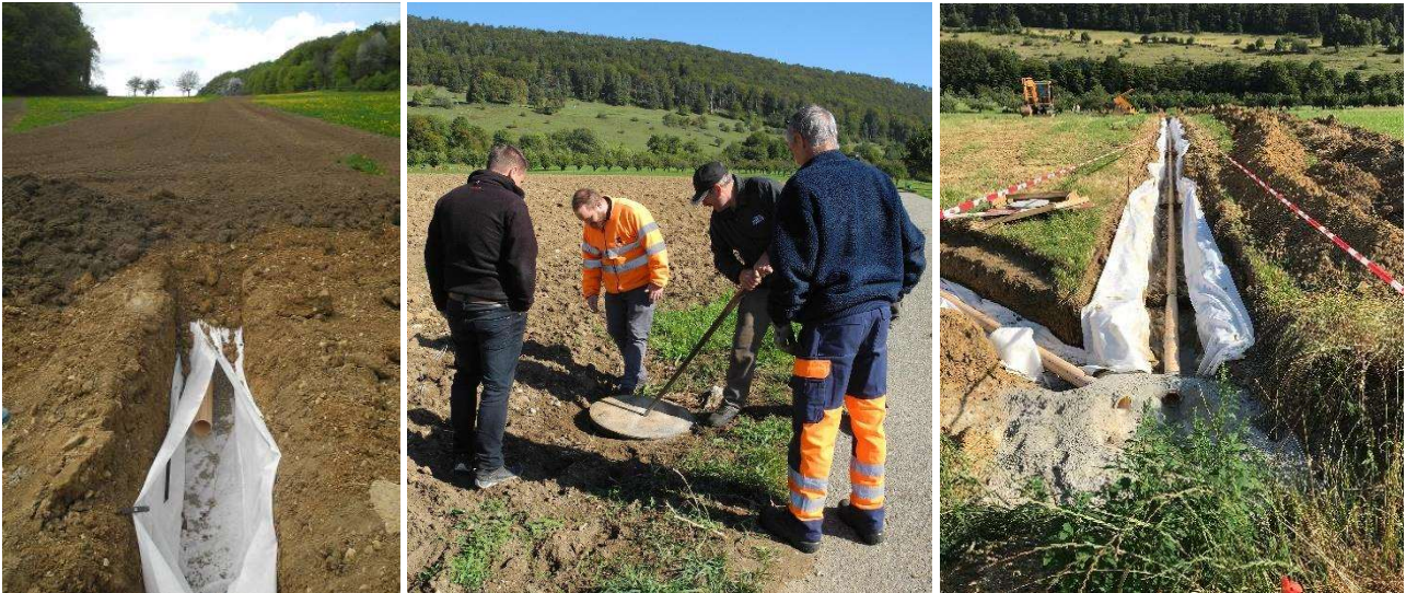
Drainage im Gebiet Hintersteimelmatten (Fotos: Ebenrain) und nördlich des Feuerwehrweihers (Foto: BSB), Etappe 6
