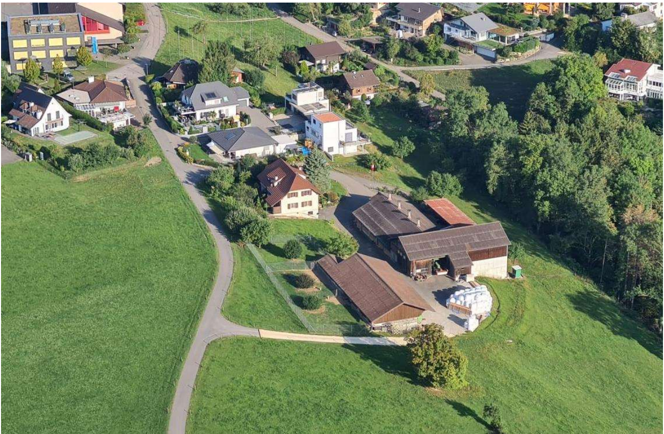
Der Hof von Patrik Jeisy nach der Sanierung der Hofzufahrt. (Foto: Florian Meury)
