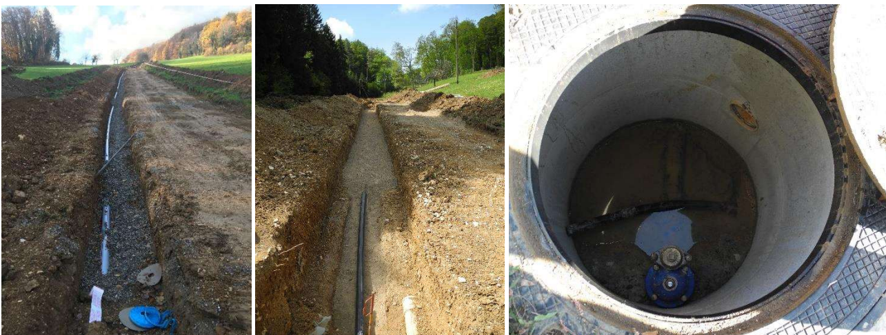
Wasserleitung im oberen (Foto: BSB) und im unteren Abschnitt inkl. Schacht mit Hydrant (Fotos: Ebenrain), Etappe 6
