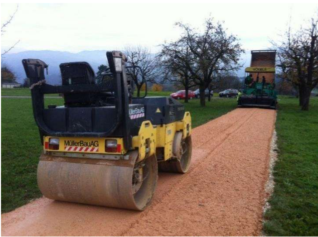
Sanierung Mergelweg im Oberfeld, Etappe 2, und Einbau Betonspuren beim Blattenpass, Etappe 3 (Fotos: Ebenrain)
