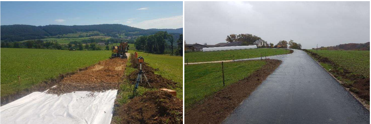
Sanierung des Laigrubenweg und des Hotzlerwegs im Strängenfeld, Etappe 7 (Fotos: Ebenrain)
