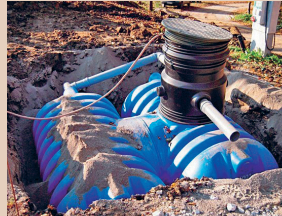
Ein unterirdischer Rückhaltetank ist frostsicher, muss aber zwingend doppelwandig sein, L. Chevalier
